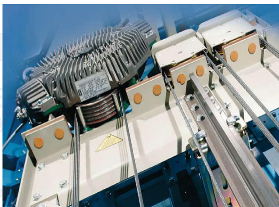
Obr.6 - Pohonná jednotka výtahu MaxiSpace
